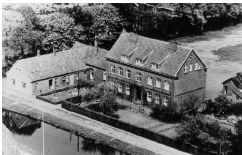
1912 - Die neue Knabenschule bei der Mädchenschule am Splittingkanal Nr.12
