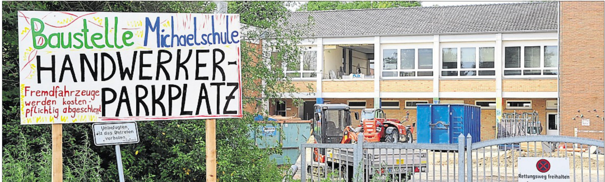
Achtung, Baustelle: Schüler haben dieses Schild gemalt.
